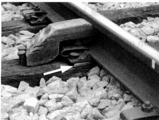
写真1 はさみ木（白い矢印）を挿入した状態の線路
