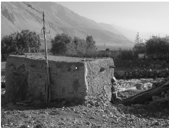
写真8 水を動力とする粉挽き小屋は小河川沿いに立地する 水の落差で石臼を回転させる。電気があってもこの小屋は健在。撮影場所：⑩村(2006年7月 筆者撮影)
