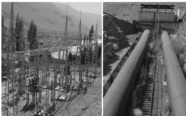
写真10 旧ソ連時代に建設された水路式発電所 1978年建設されたが故障が多く停電が日常茶飯事。撮影場所：㉔村付近 (2006年7月筆者撮影)
