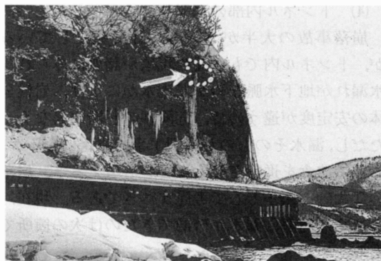
写真3 立岩付近の崖（矢印の部分が落下）
