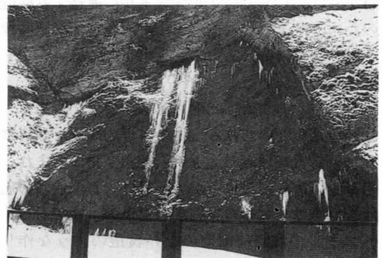
写真8 事故現場の岩体剥離面。crack部分から滝線のように20mに近いツララが下る。
