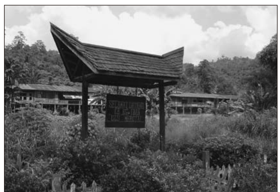
Fig. 2. Longhouse in Kampung Iban Ulu Merotai (Rumah Lutut).
